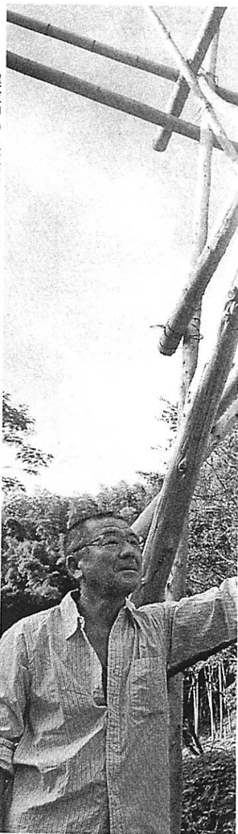
建設中の上総掘りを見上げる白石さん。地域文化財の復元もまち興しの一環だ(千葉県君津市で)
